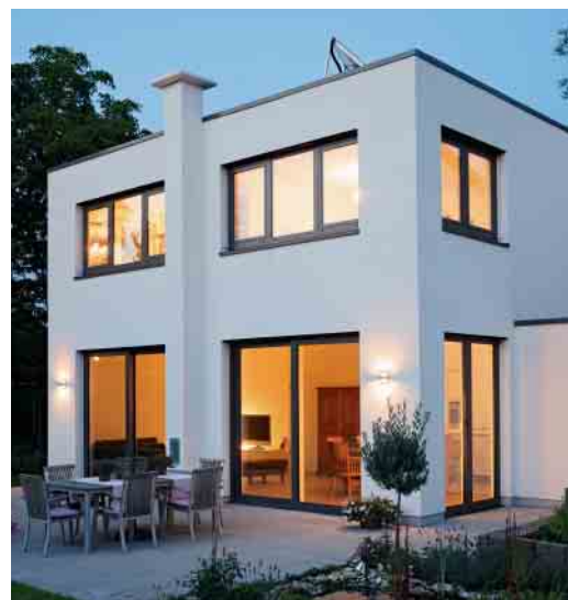
Une technique de fenêtre de grande qualité dans des constructions modernes.
