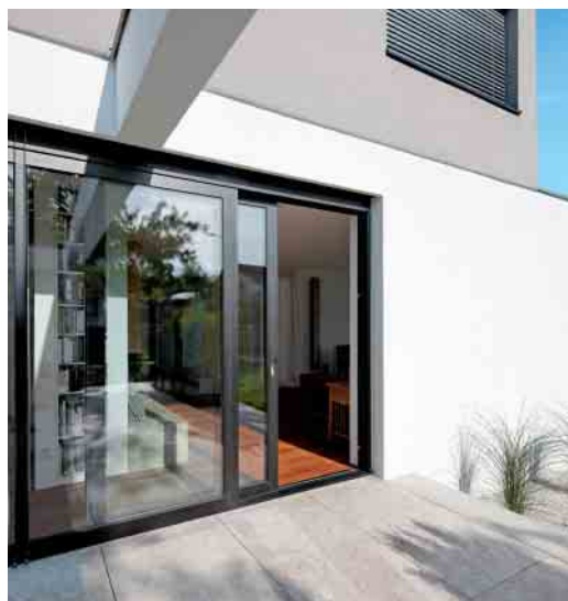
Rénover dans le respect du style et avec empathie – ou comment conserver le caractère d'une maison.
